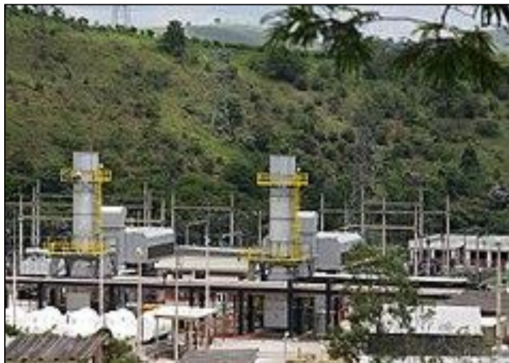
Figura 1.16 – Imagem fotográfica da usina termoeétrica de Juiz de Fora – MG.
